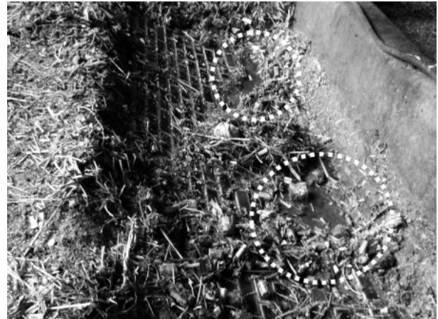
（写真1）飼槽床面の侵食は細菌の温床となるので注意
