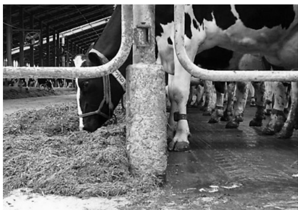
(写真3) 飼槽床面は通路より高く
