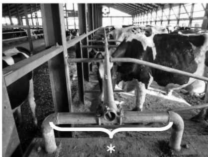
(図6) フリーストールのネックレールを前後移動できるための工夫 *で示すようにネックレールが前後に移動しやすいつくりとなっている
