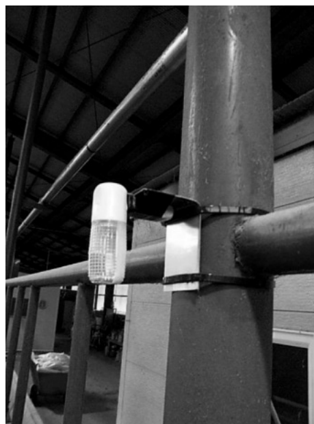
（写真5）差込式簡易LEDを固定
