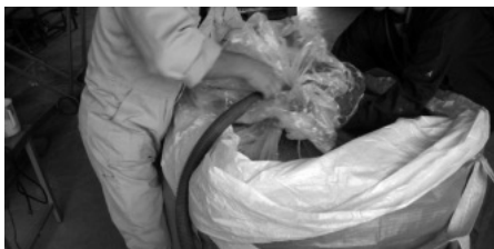
貯蔵袋（フレコンバック）から掃除機で空気を吸引
