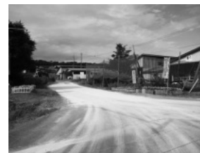
消石灰帯の設置
