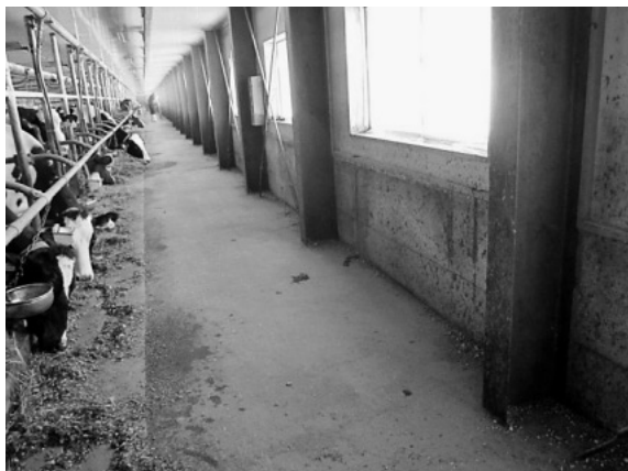
(写真1) 結露していない壁面
