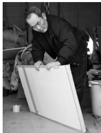
(写真4) 発泡スチロール、電気毛布、PPプレートをガムテープで固定して完成する
