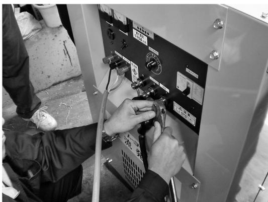
(写真3) 単相および三相電源の結線作業
