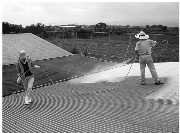
（写真1 石灰乳塗布の様子）
