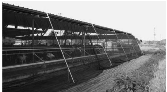
(写真) 「簡易低コスト防虫ネット」を設置したフリーストール乳牛舎。 平成20年、サシバエの休息場所(隣接農地)がある2側面のみに設置。 単管パイプに防風ネット(2mm)を取り付け、約25万円で施工。
