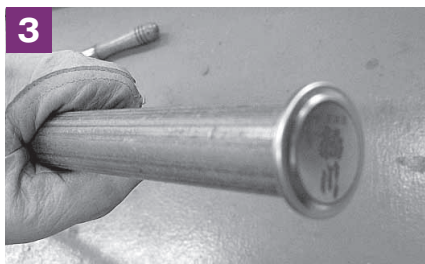
3 パイプの末端にワッシャー等を溶接
