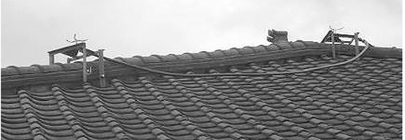
(写真1) 畜舎屋根に設置された井戸水を利用したスプリンクラー
