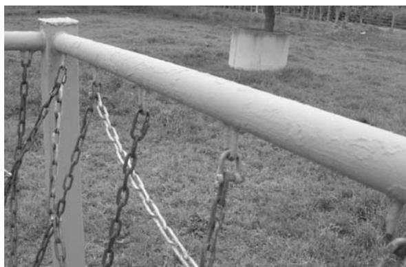
(写真1) 上部支持枠 チェーン接続部
