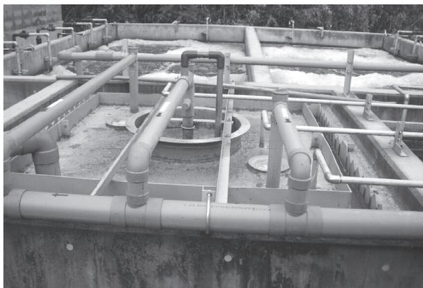
(写真4) 最初沈澱処理設備
