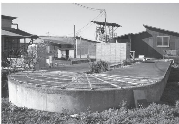
(写真6) 回分式活性汚泥処理設備（希釈有）
