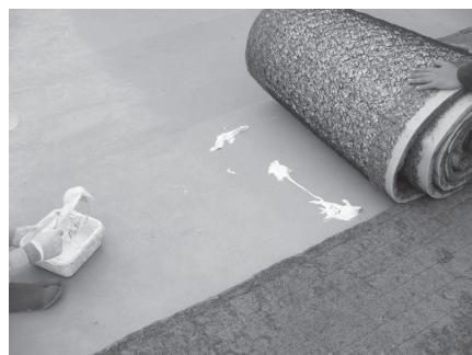
(写真2) コケマットの施工
