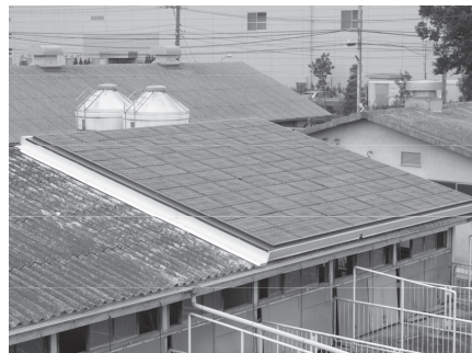
(写真1) 豚舎屋根の緑化
