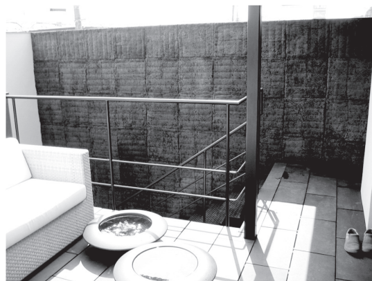
(写真 3) 壁面緑化
