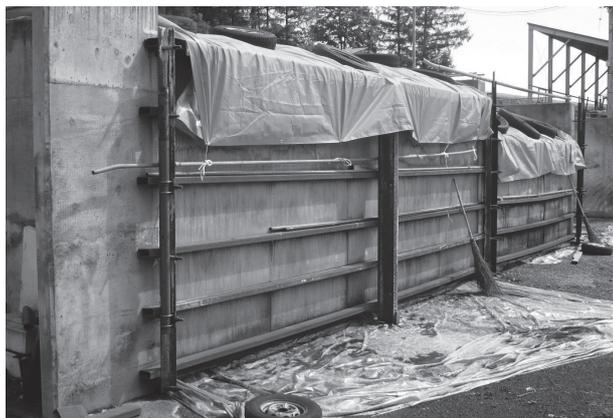
(写真7) バンカーサイロのロスを防止する可動式の壁
