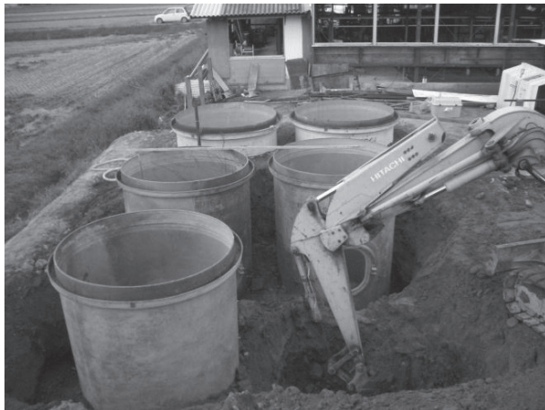
(写真1) サイロを1本ずつ埋設
