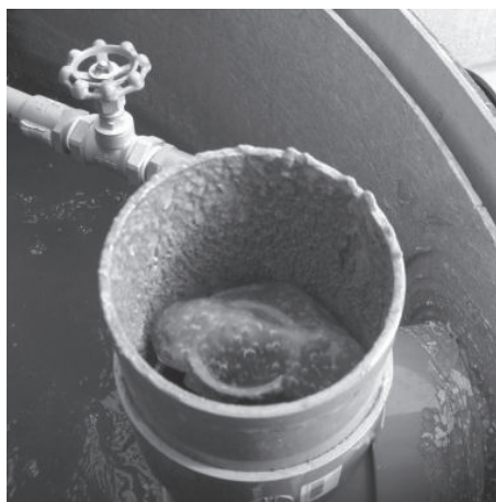
(写真5) リフトアップされた汚水
