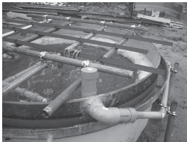
(写真10) エアリフトポンプと配管
