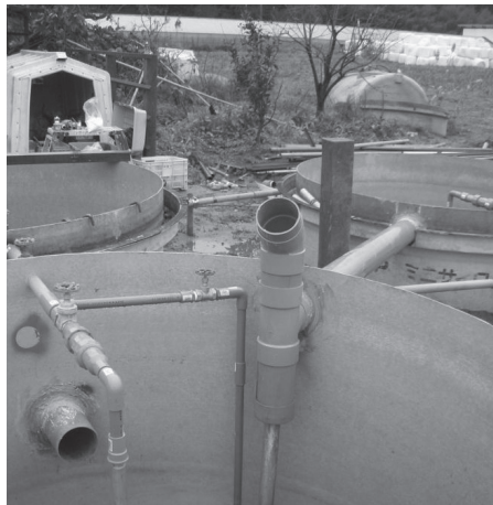
(写真4) エアリフトポンプ
