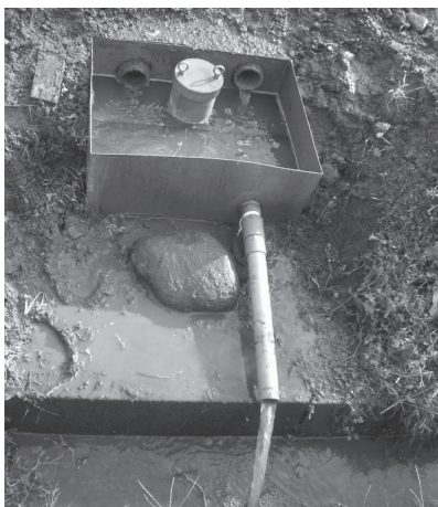
(写真9) 消毒槽と放流水
