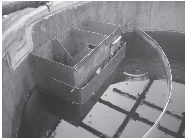
(写真8) 仕切った沈殿槽
