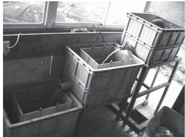
(写真2) 3段状の固液分離装置
