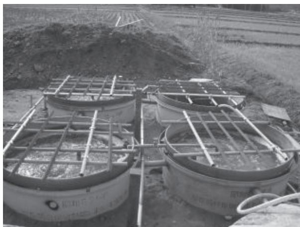
(写真6) ばっ気槽の様子
