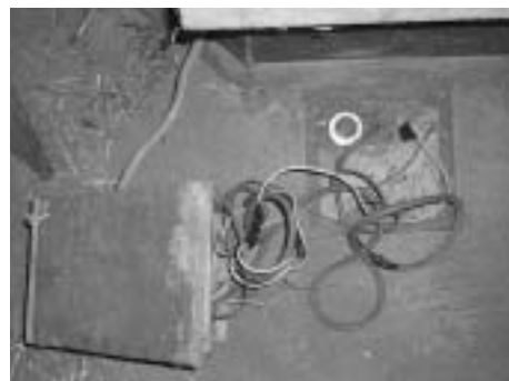
(写真2) 自動温度調節器(写真右上)を牛房の外に埋め込んでいる。左のボックスはネズミ除け
