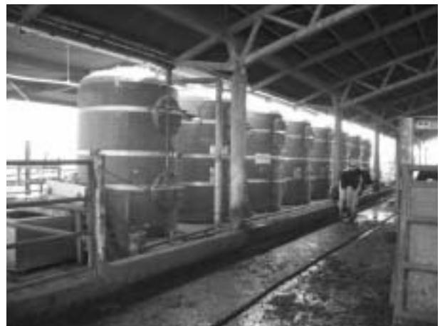
(写真4) FRPサイロを活用した施設全景
