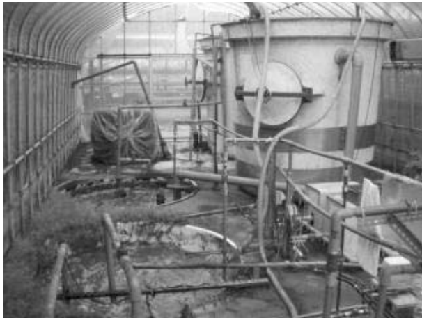
(写真1) 処理施設の様子
