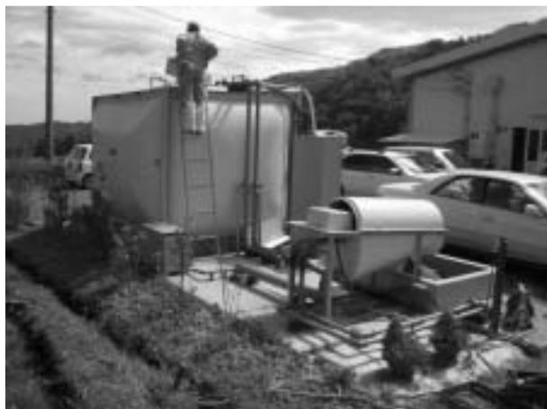
(写真2) 回分式浄化槽
