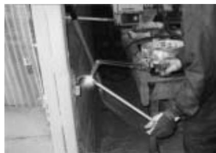
（写真1）鉄筋の曲げる部分をガスバーナーで赤く焼き手で曲げます
