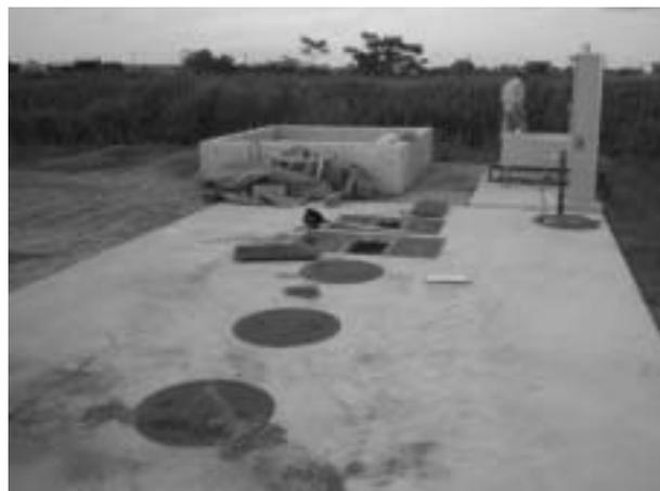
(写真1) 人用合併浄化槽
