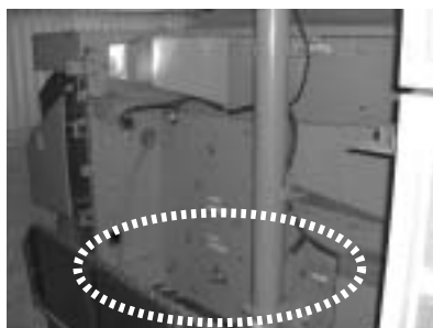
（写真8）米タンクを外した部分
