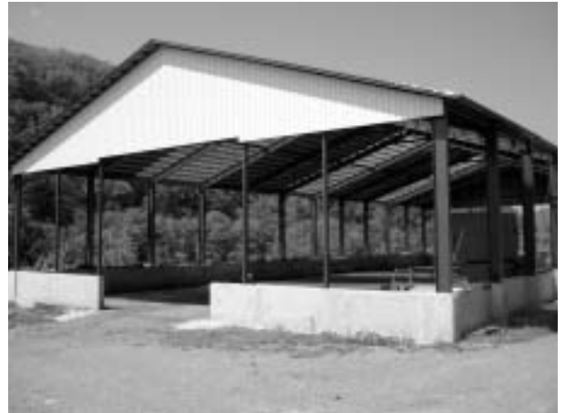
(写真5) 完成したたい肥舎
