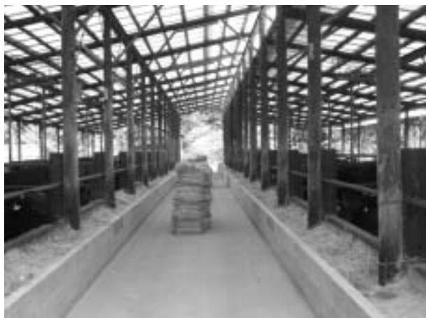
新設した肥育舎
