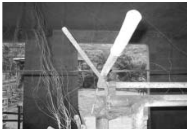
（写真2）拘束時における鉄筋の位置
