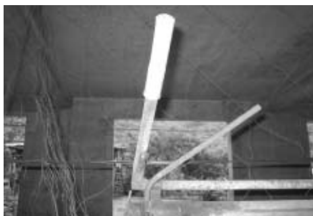
（写真3）解放時における鉄筋の位置
