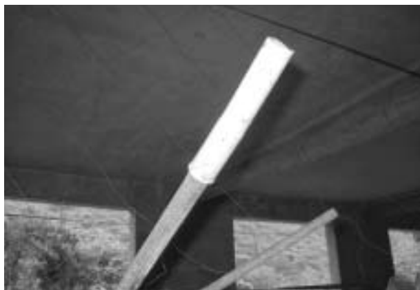
（写真1）塩ビパイプ装着
