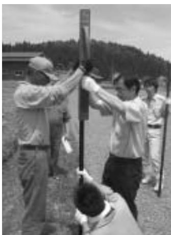
（写真1）大支柱の打ち込み
