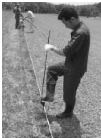
（写真2）小支柱の打ち込み
