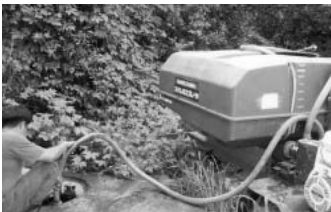
（写真3）尿汲み上げ作業
