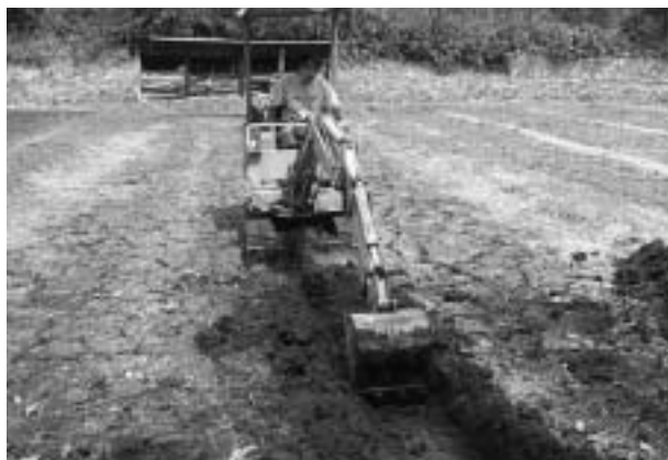
（写真3）溝を切って排水対策
