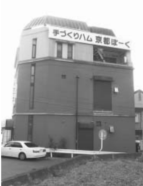
(写真1) 加工処理施設の全景
