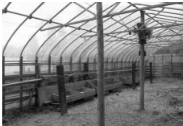
写真-6 ビニールハウスを補強して使っている簡易牛舎
