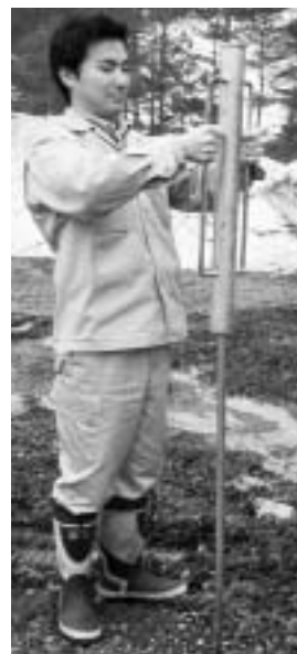
写真-8 牧柵支柱を地面に打ち込むとき、片側を溶接で塞いだ5kg程度の鉄管 (写真-9)を使うと作業が大変楽になる
