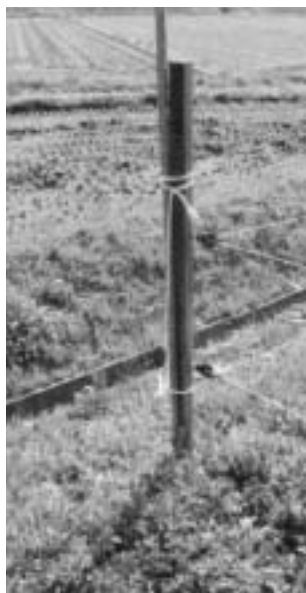
写真-6 簡易牧柵支柱B (鉄管+角材+碇子)
