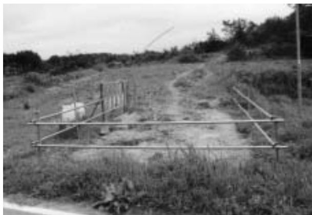
写真-12 単管パイプによる追い込み柵
