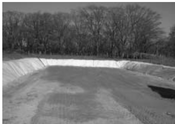
写真 - 3 高水分ふん尿に対応した盛土の例
