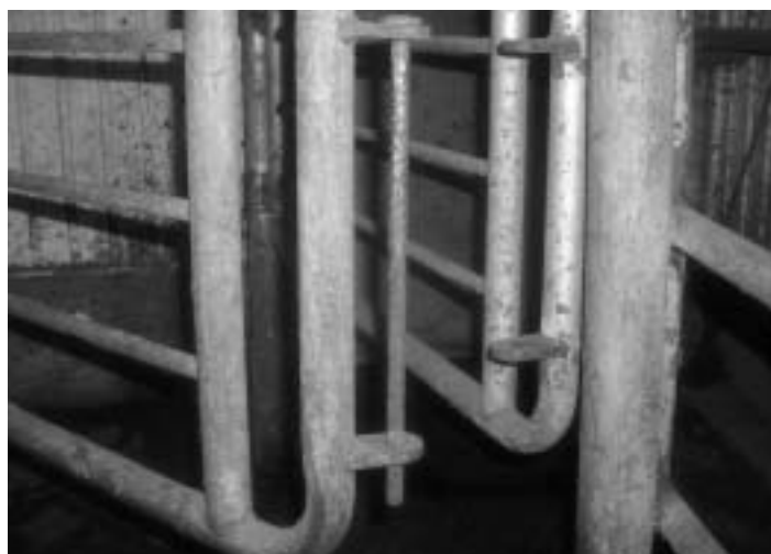
写真 - 3 簡単に取り外しができるゲートのロック
