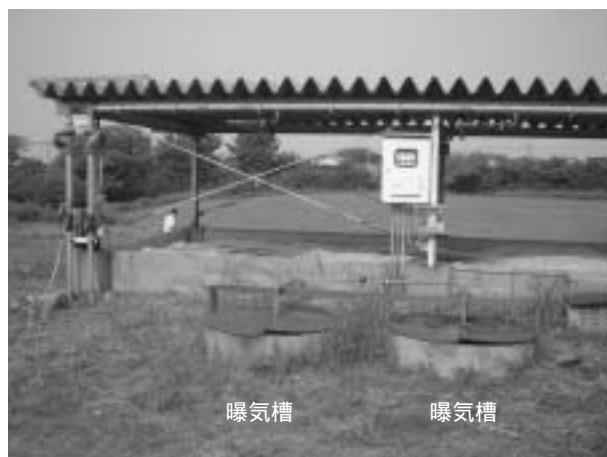
写真 - 1 畜産試験場の簡易曝気槽
