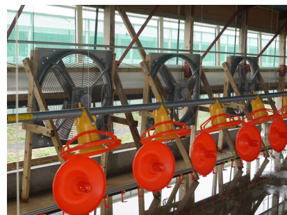
平成20年にLED照明に切り換えた
