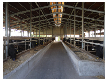
平成9年に補助事業を活用し建設した牛舎内部
