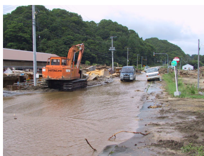
牛舎前の道は重機でガレキを寄せ、車両の通行を確保した
