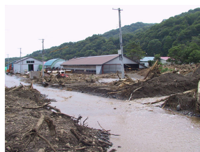
内部に90cmもの土砂が流入した牛舎
