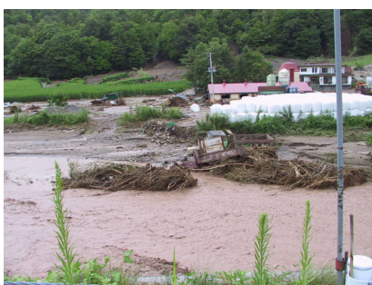
土砂のほか流木等が堆積した
