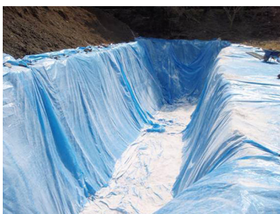
掘削後のシート張り
