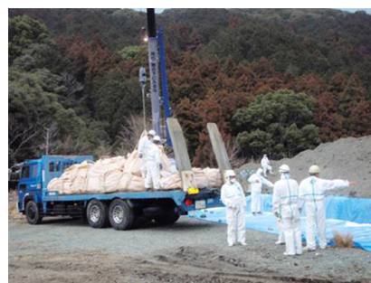
クレーン車による汚染物の投入作業
