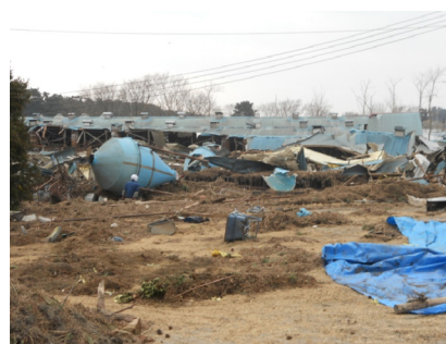
◎津波により全壊した豚舎
