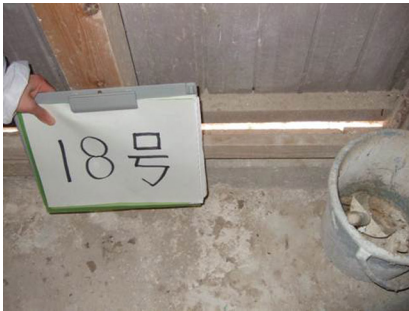
すき間の点検修繕
