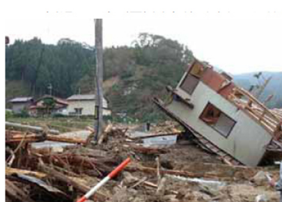
平成16年台風23号による被害（豊岡市但東町）
