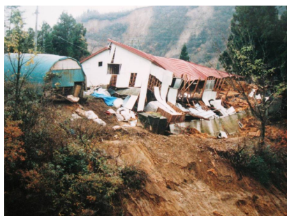
倒壊した牛舎
