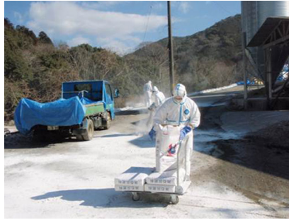
敷地内石灰散布作業の様子
