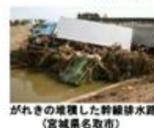
がれきの堆積した幹線排水路 (宮城県名取市)
