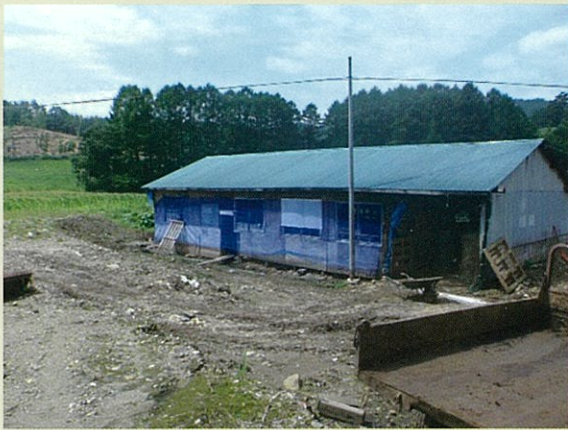
牛舎の周囲にネットを設置 (農場への侵入防止)
