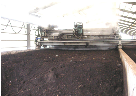
バイオマスセンター（旧堆肥センター）
