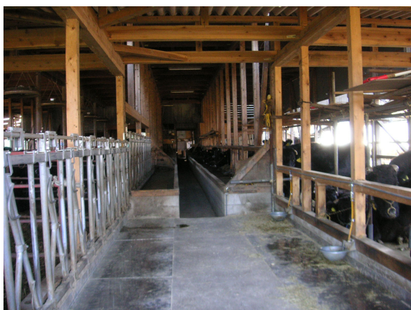
増築した牛舎。連動スタン ションが付いた手前半分が増 築部分。
