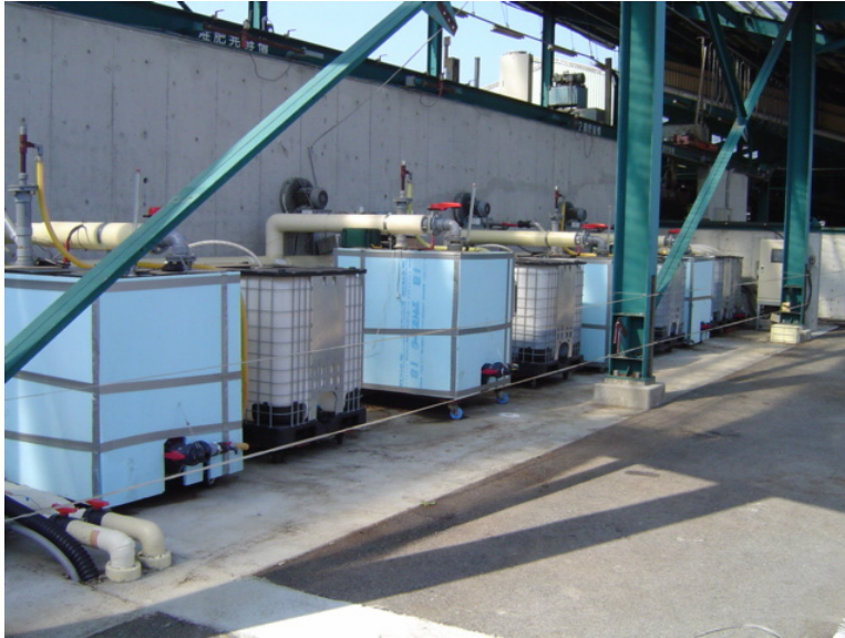
写真5. 実証プラントに設置した試作スクラバ
