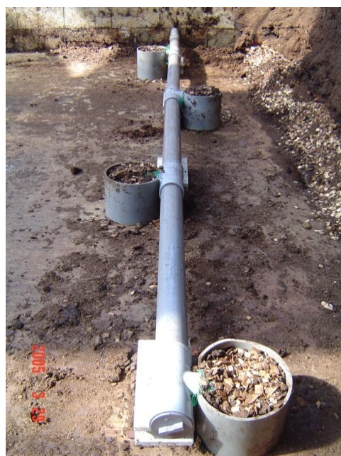
写真 2. 吸引通気方式用の通気口
