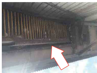
左の写真の部分を下から
