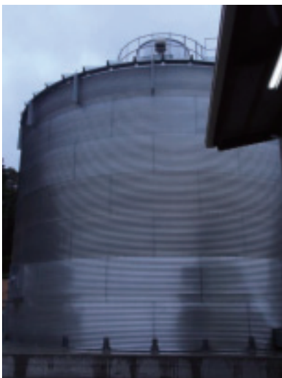
【写真 1 新設した鉄板サイロ】
