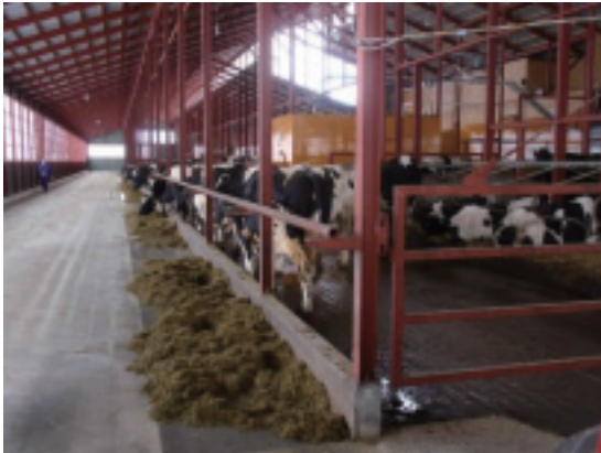
【写真1 新設したフリーストール牛舎】
