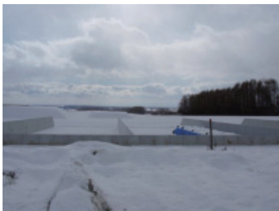
【写真 5 新設したバンカーサイロ】
