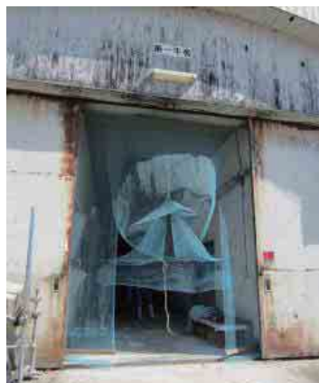
重機等の出入りのためネットの下側にパイプを通し、ロープを手繰ることで開閉できる。
