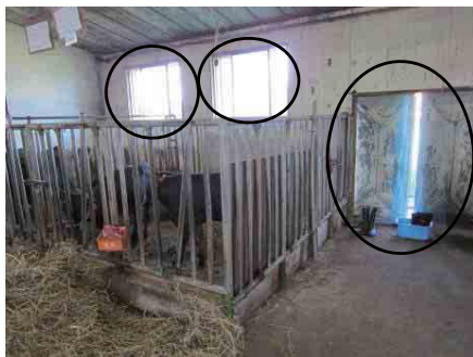
牛舎内の窓、出入り口全てに木枠に貼り付けたネットを設置した。
