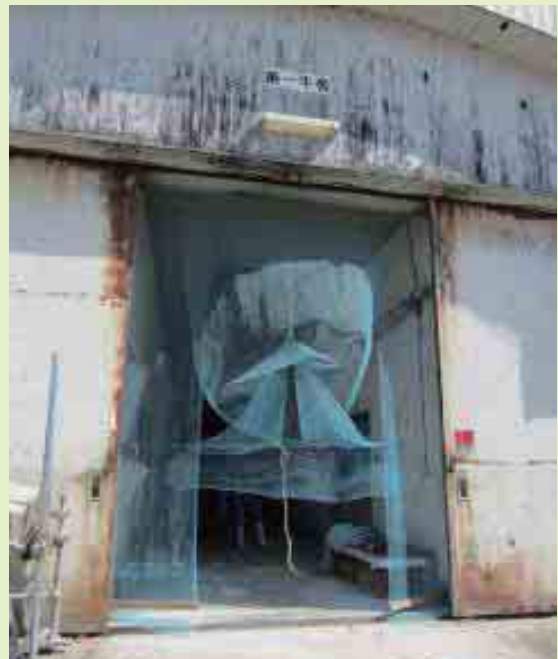
重機等の出入りのためネットの下側にパイプを通し、ロープを手繰ることで開閉できる
