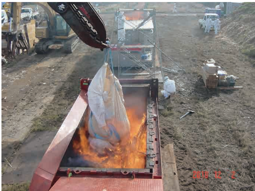
移動式焼却炉による焼却作業 (非組立式 (手前)、組立式 (奥))
