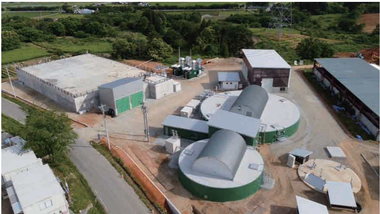
バイオガス発電所
